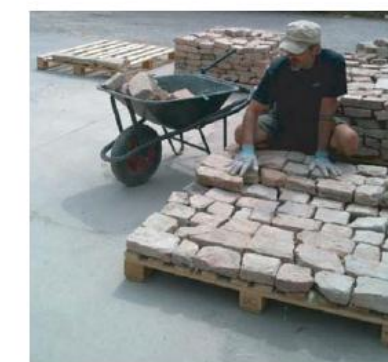
Volontari all'opera nel recupero dei materiali crollati
