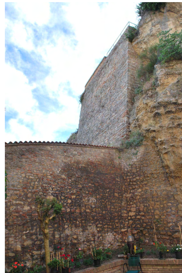
Muri di confine e di contenimento addossati alla parete in roccia affiorante (UMI 149)
