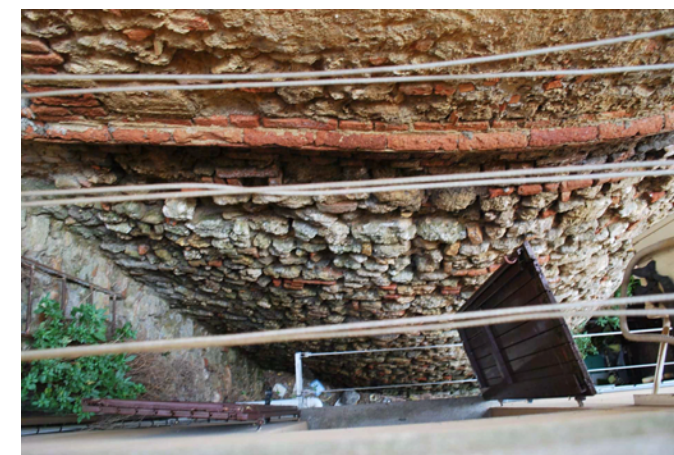
Particolare della muratura del torrione delle mura in conci di pietra spungone e cornice in cotto (UMI 120)
