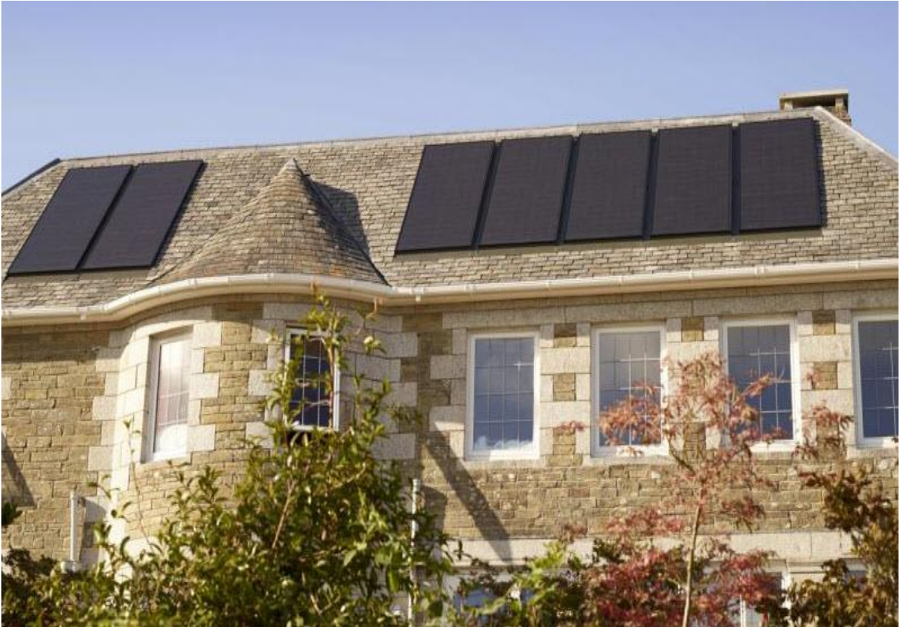
(Esempio di impianto fotovoltaico su un'abitazione soggetta a riqualificazione energetica)
