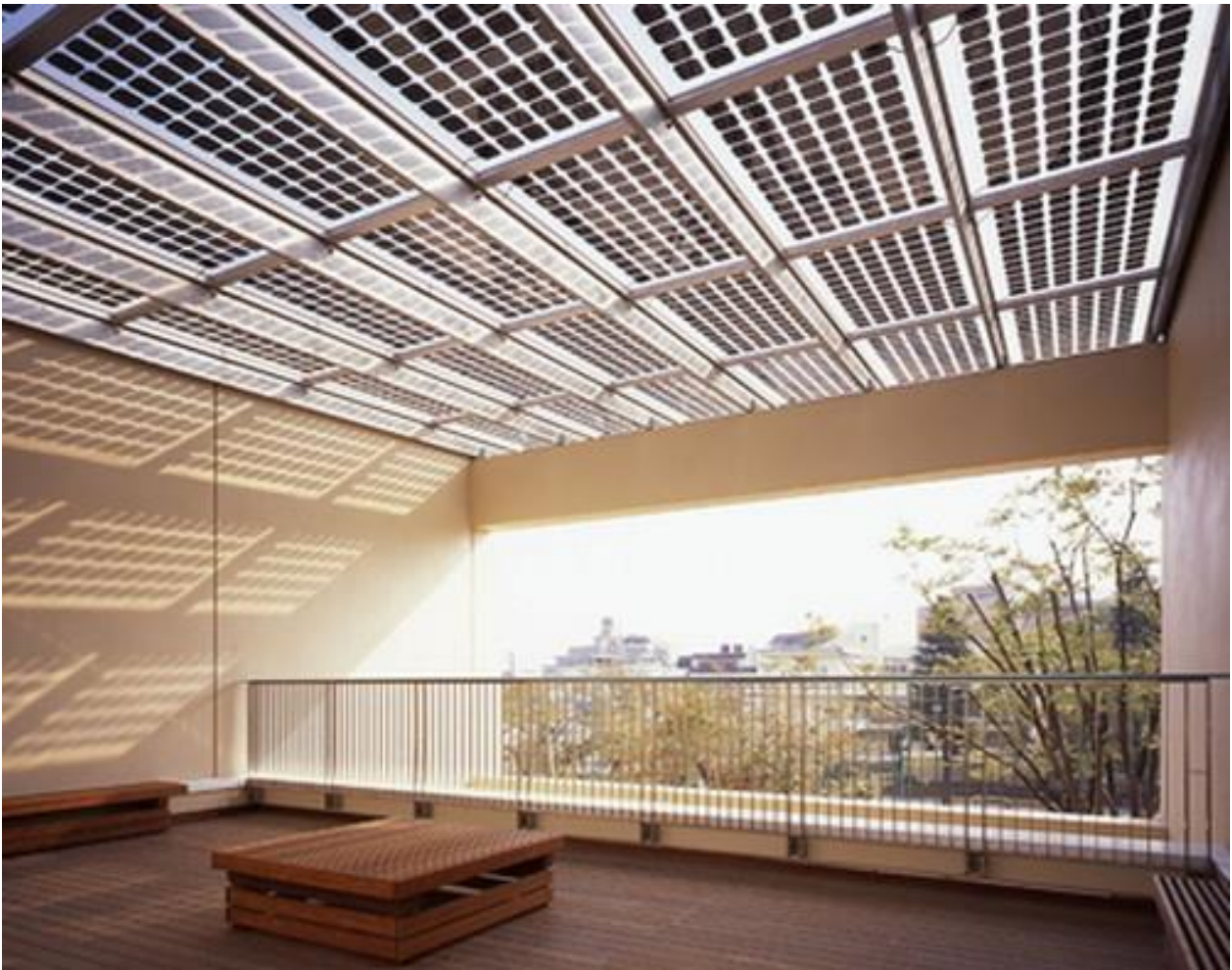
(Esempio di installazione di pannelli termici vetrati: la caratteristica principale è la trasparenza)
