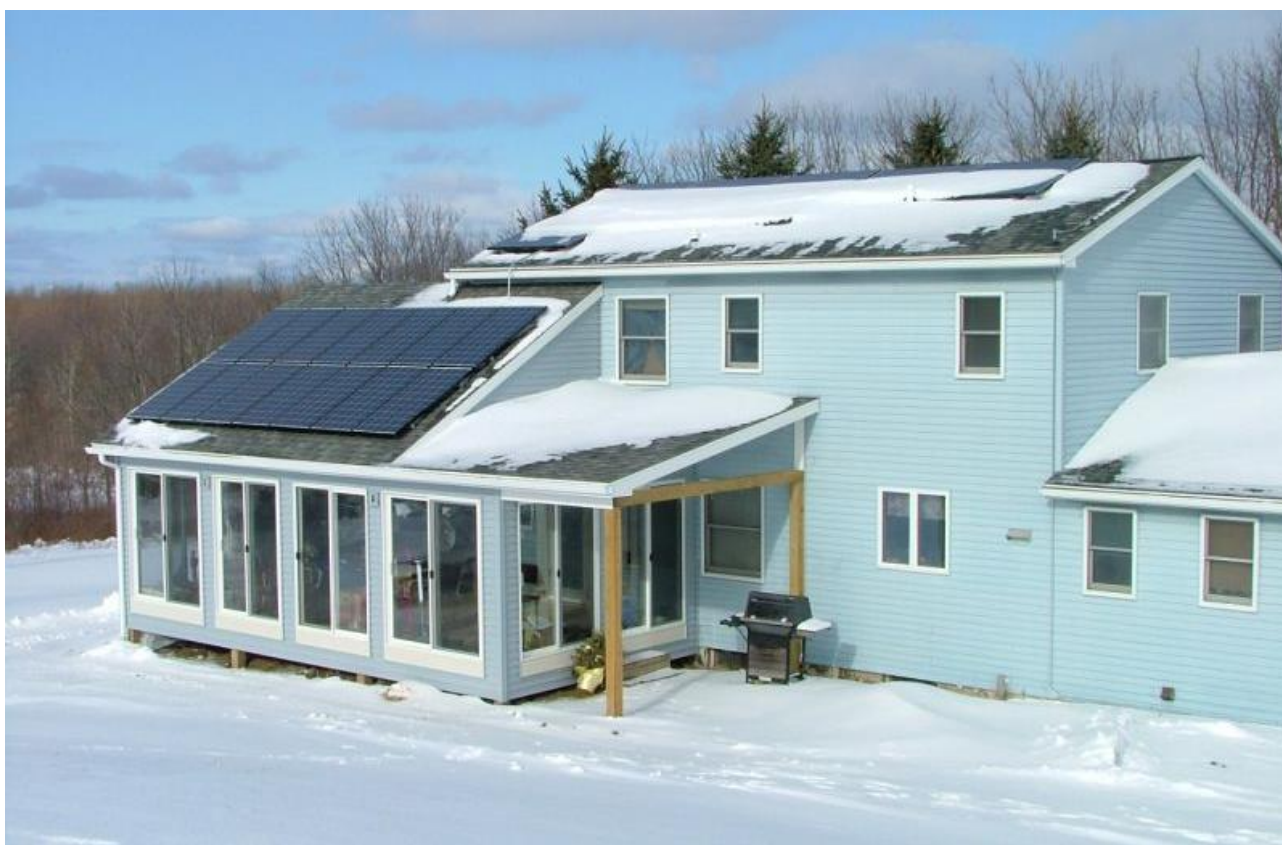
(Pannelli fotovoltaici ricoperti da neve e ghiaccio)
