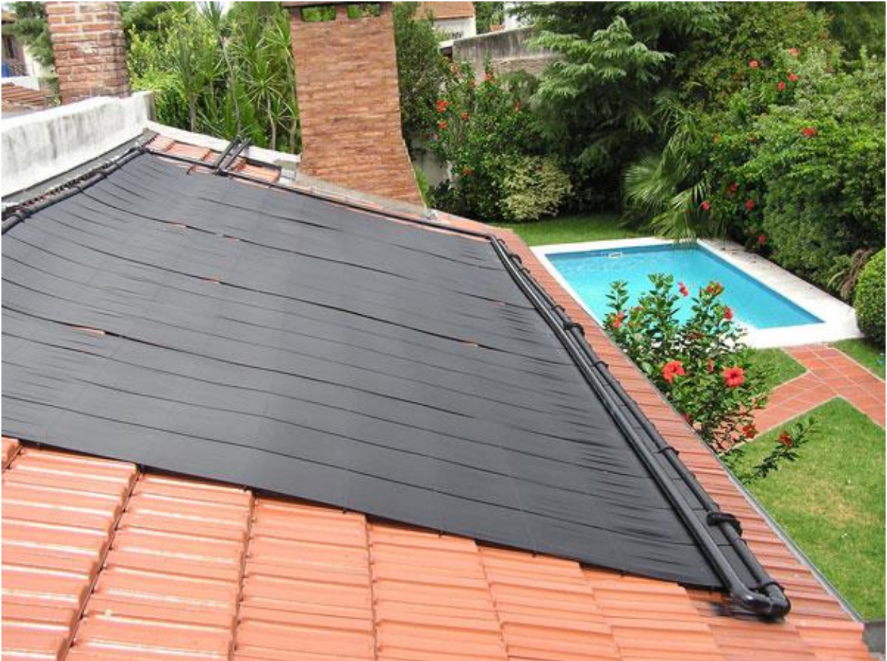
(Esempio di installazione di pannello termico per il riscaldamento dell'acqua della piscina)
