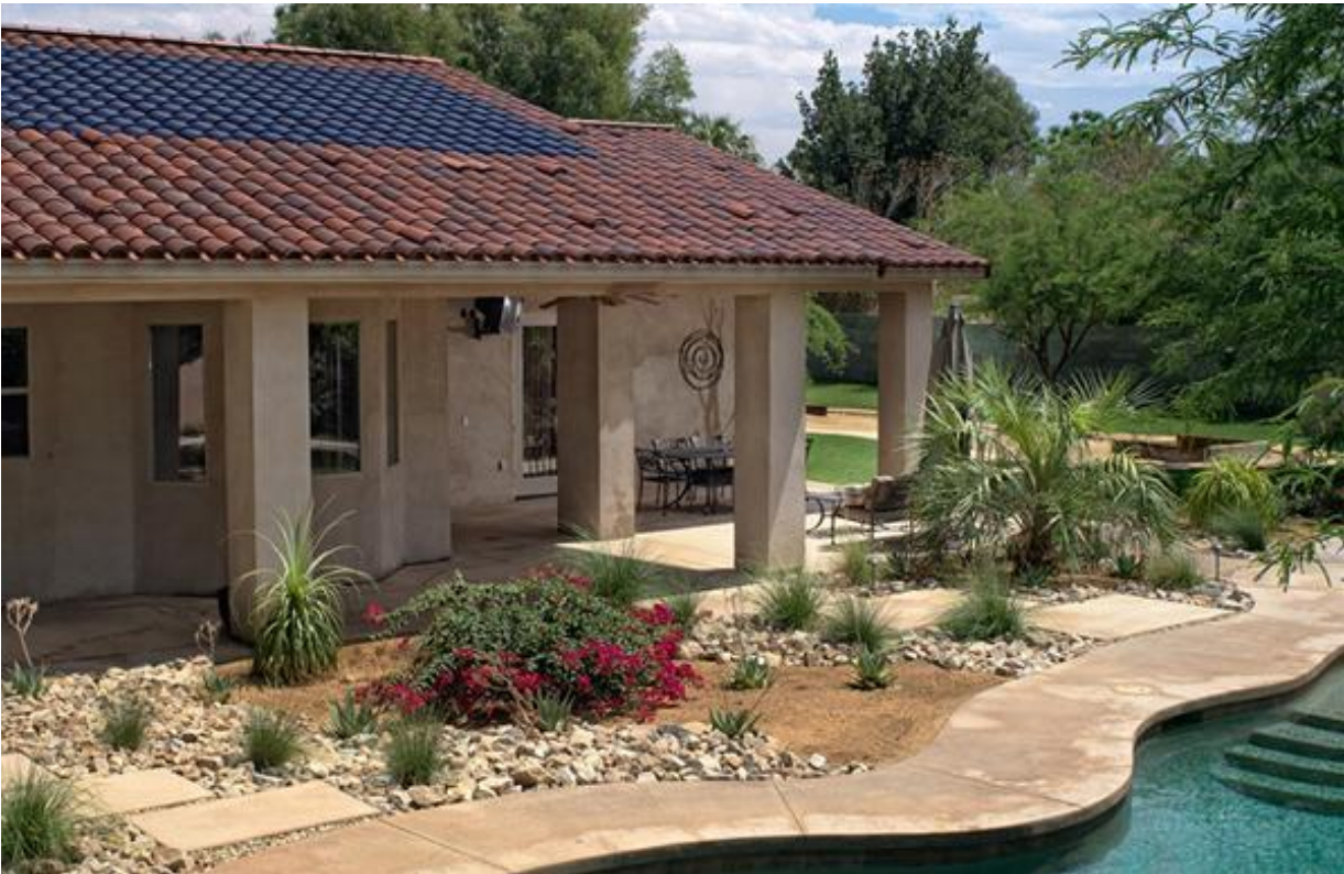
(Impianto fotovoltaico integrato sul tetto. Nel dettaglio: tegole fotovoltaiche blu)
